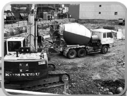
▲ 正德醫院工程擋土牆施工之灌漿及鋼筋綁紮工程
