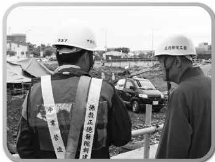
▲ 4/27 開山和尚巡視醫院工程進度
